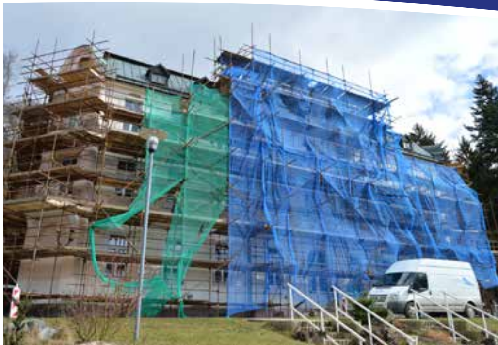
Komplexní rekonstrukce lázeňského domu Záboj probíhá na plné obrátky. Plánovaný termín dokončení bude dodržen.
